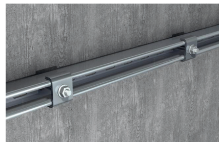
Монтаж шин к стене
