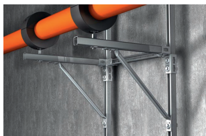
Усиление монтажной шины
