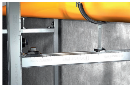
Крепление трубопровода на рамную конструкцию
