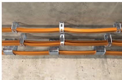
Крепление кабелей к перекрытию
