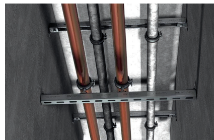
Крепление трубопровода в узких пространствах
