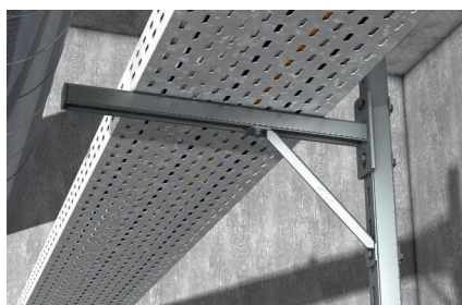
Крепление кабельного канала на консольную конструкцию
