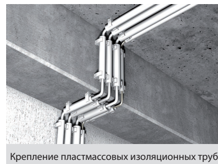
Крепление пластмассовых изоляционных труб
