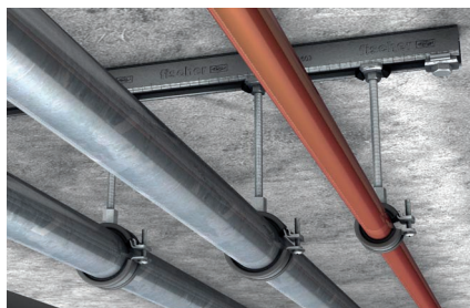
Крепление трубопровода с помощью монтажной шины
