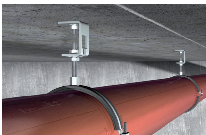
Монтаж трубопровода с регулировкой по высоте
