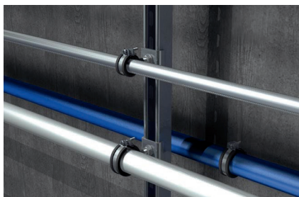
Монтаж поперечных труб к шинам
